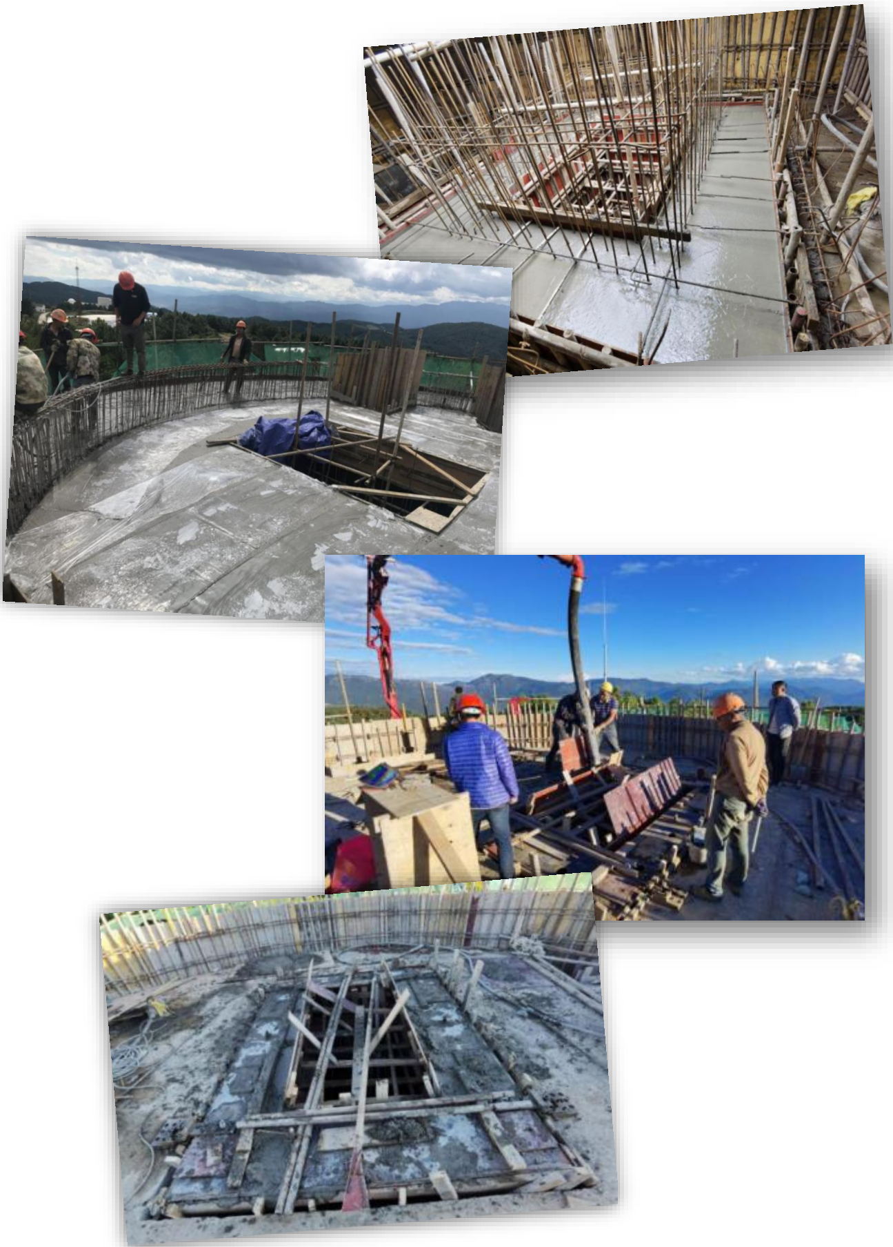
图 3.8：自上而下：第二段基墩完成浇筑；建筑物五层完成浇筑；第三段基墩浇筑
