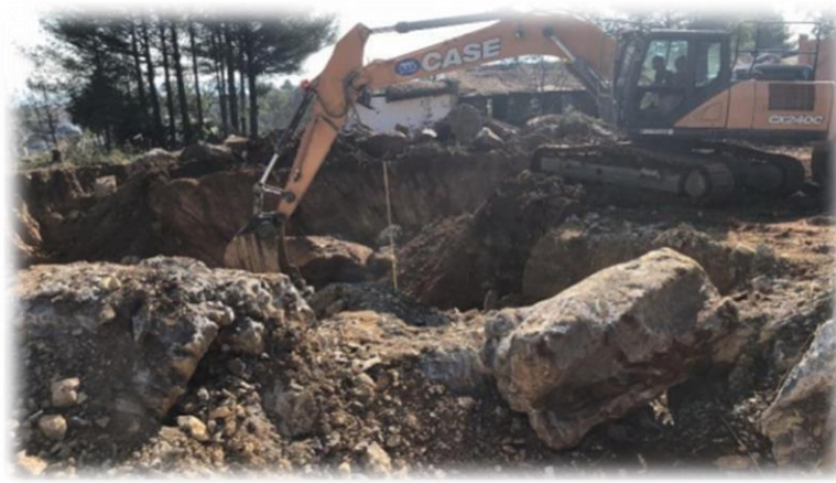
图 3.4: 基岩开挖 Bedrock excavation
