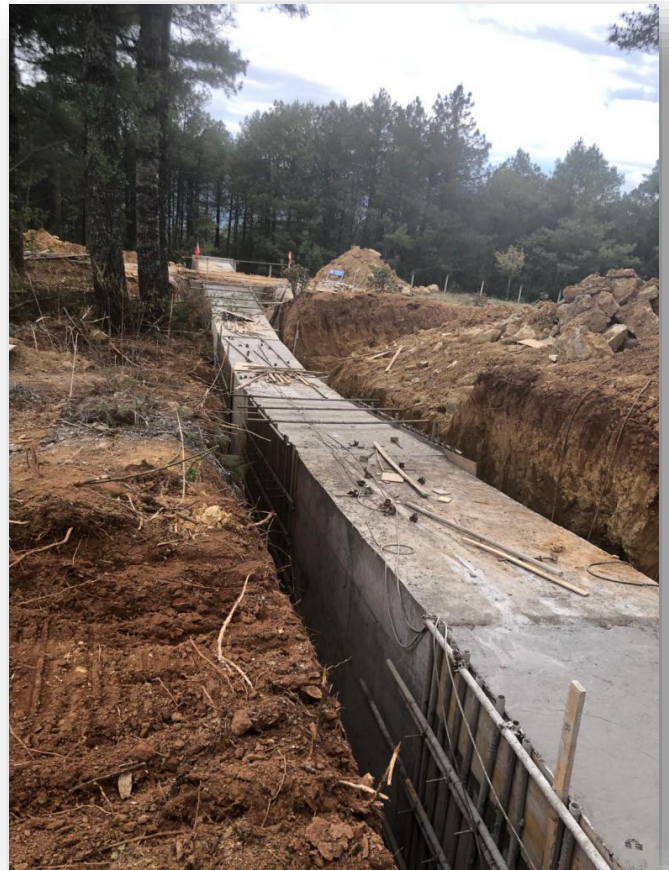
图 3.3: 主风道浇筑完成 Concreting the main ventilation tunnel
