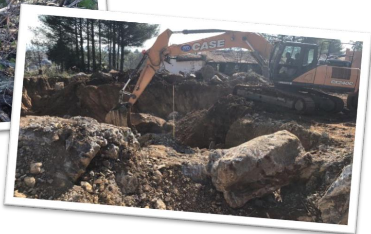
图 3.2: 基岩开挖 Bedrock excavation
